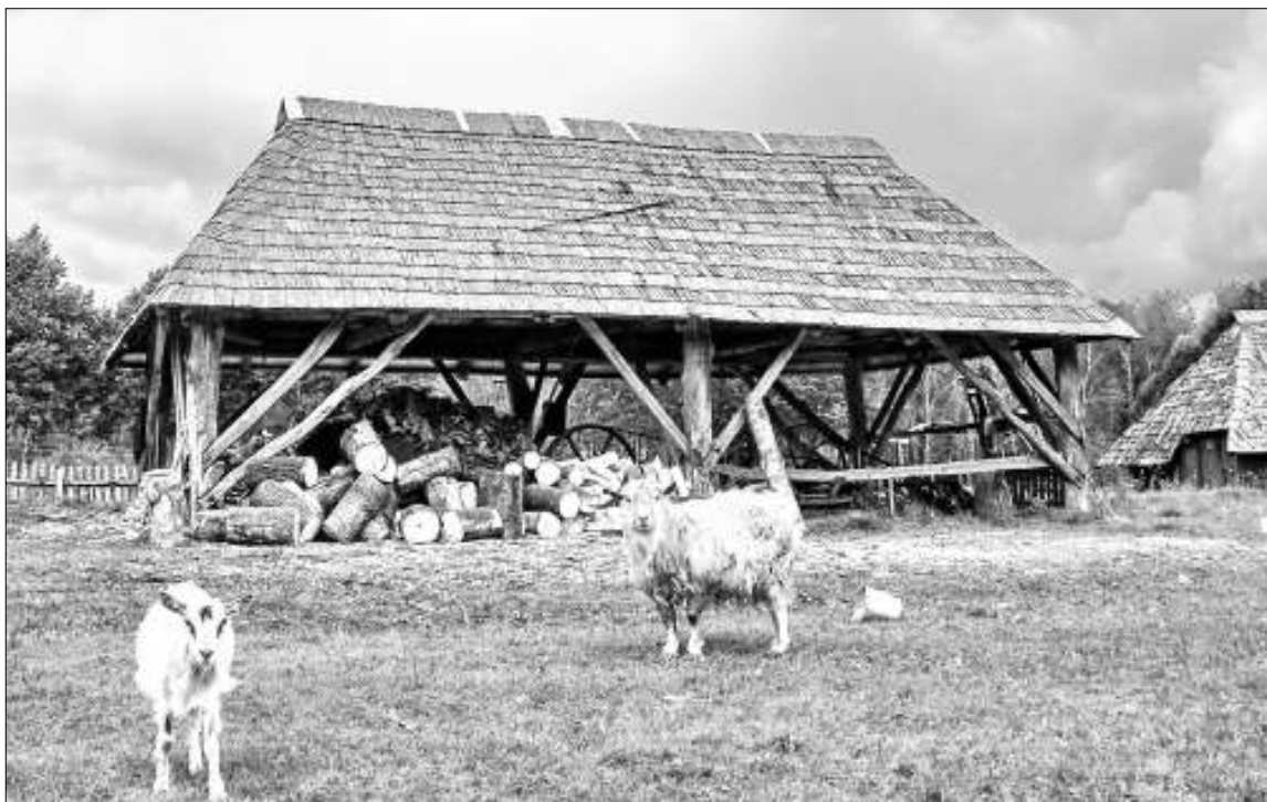
Žardinė ( žardinyčia ), skirta linams, žirniams, šienui ar pašarams džiovinti, pasiturinčio žemaičio sodyboje. Žardinė 6 x 12 m. XX a. pradžioje stovėjo Plungės r. Platelių sen. ūkininko Prano Šetkausko sodyboje. 1951 m., vykstant kokyvizacijai, atiteko kolūkio nuosavybėn. 1975 m. buvo perduota ŽKM
