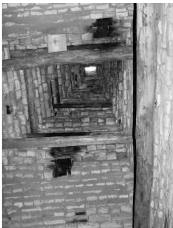
Siaurėjantis į viršų kaminas (virenė), sumūrytas iš degtų molio plytų, pasiturinčio žemaičio troboje. ŽKM
